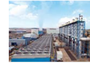
Şanlıurfa Akaryakıt Santrali
