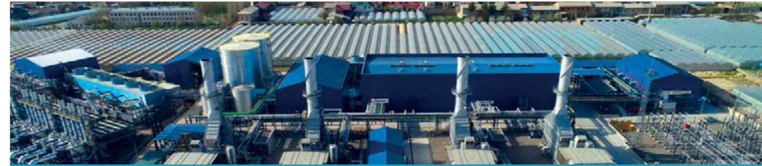
Özbekistan, Taşkent A Doğal Gaz Kombine Çevrim Santrali
