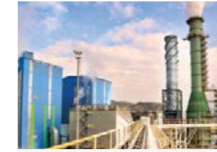
Bolu, Göynük Termik Enerji Santrali
