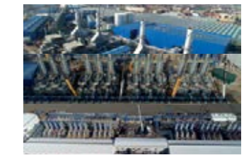
Özbekistan Doğal Gaz Kombine Çevrim Santralleri
