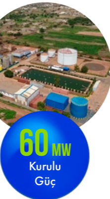
Mali Akaryakıt Enerji Santrali
