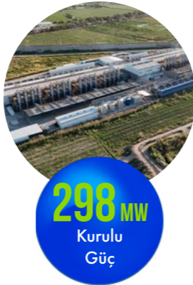
Buhara Doğal Gaz Kombine Çevrim Santrali Özbekistan
