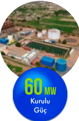
Mali Akaryakıt Enerji Santrali
