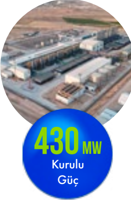
Talimercan Doğal Gaz Kombine Çevrim Santrali Özbekistan
