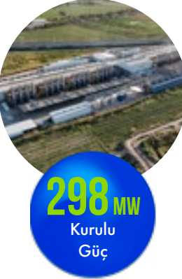
Buhara Doğal Gaz Kombine Çevrim Santrali Özbekistan
